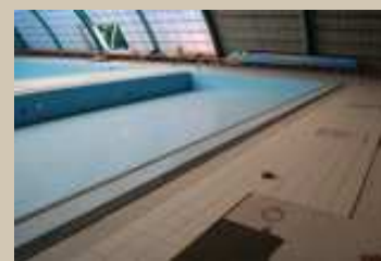
Un nouveau carrelage est en train d'être posé.
