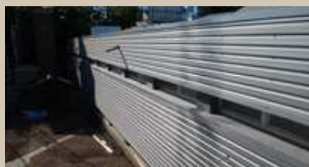
Une isolation des murs et de la toiture des vestiaires a été mise en place.
